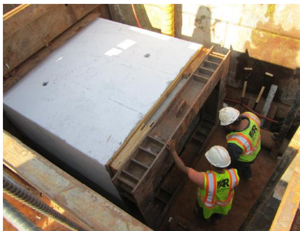
Figura 17 - Anel de distribuição de carga dos atuadores
