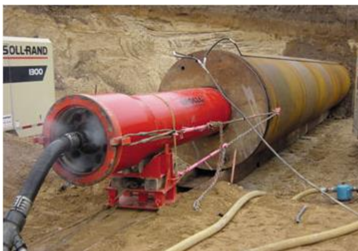
Figura 22-Máquina pneumática de cravação dinâmica
