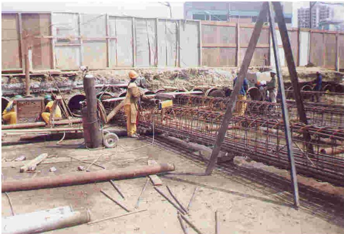
Figura 24 - Inserção das armaduras na viga tubo
