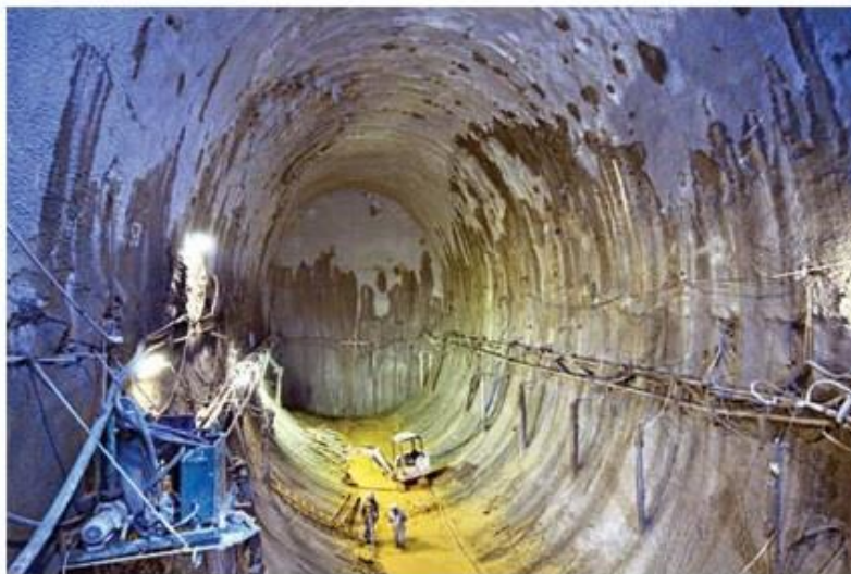
Figura 6 - Túnel em NATM da estação Higienópolis do metrô de São Paulo
