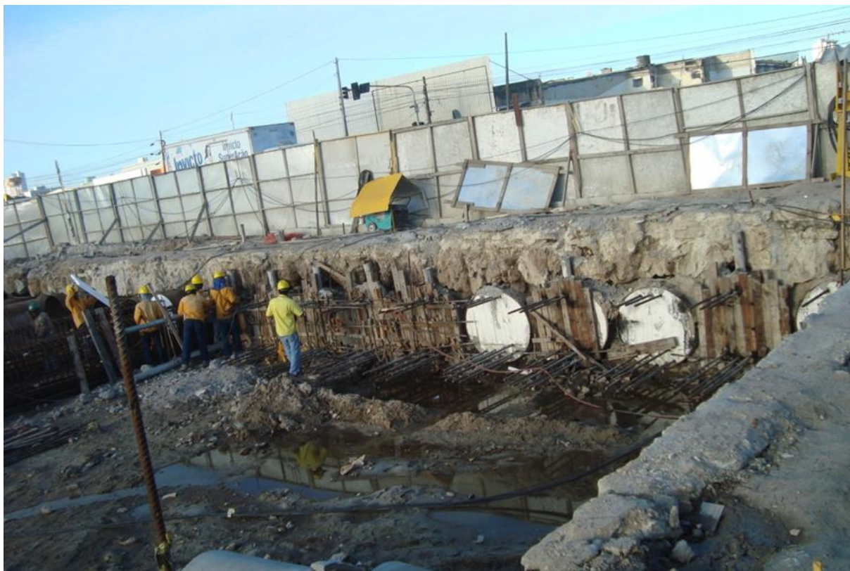
Figura 25 - Enfilagens concretadas e esperas
