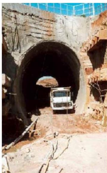
Figura 10 - Detalhe do emboque em cortina atirantada
