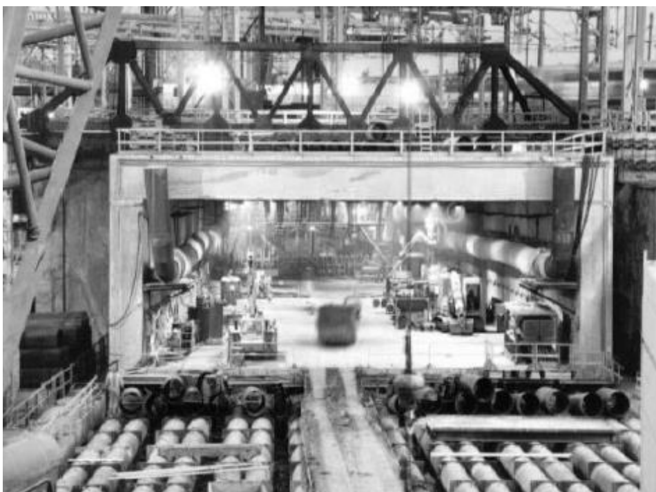
Figura 14 - Galeria pré-moldada inserida no subsolo de Boston
